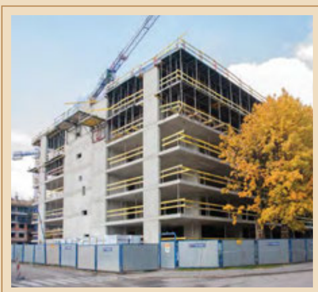
Na zdjęciach – w trakcie budowy: Puławska 255 (fot. Tomasz Bąk) Elsnera 34 (fot. Tomasz Bąk) Mozarta – Dom nad Dolinką (fot. Jacek Sasin)
