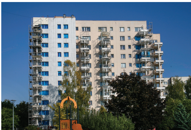
W budynkach przeprowadzono szereg prac remontowych
