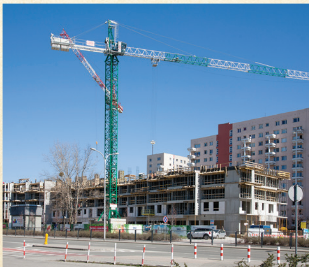
Inwestycja przy ul. Sonaty w trakcie budowy
