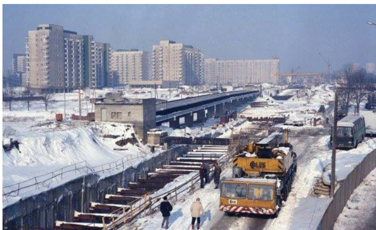
Budowa pierwszej linii warszawskiego metra
