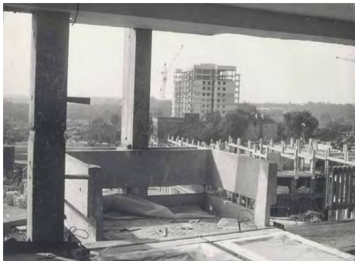
Ruszyła budowa – widok z budynku przy Wałbrzyskiej 19 na powstający budynek przy Bacha 26
