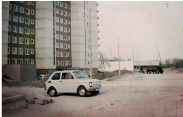
„Chemikaliowiec” – dom przy ulicy Wałbrzyskiej 19, widok w stronę Puławskiej, za nim budujący się pawilon Mokpolu
