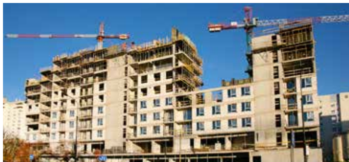
Tak wyglądała nasza budowę w listopadzie 2024 r.
