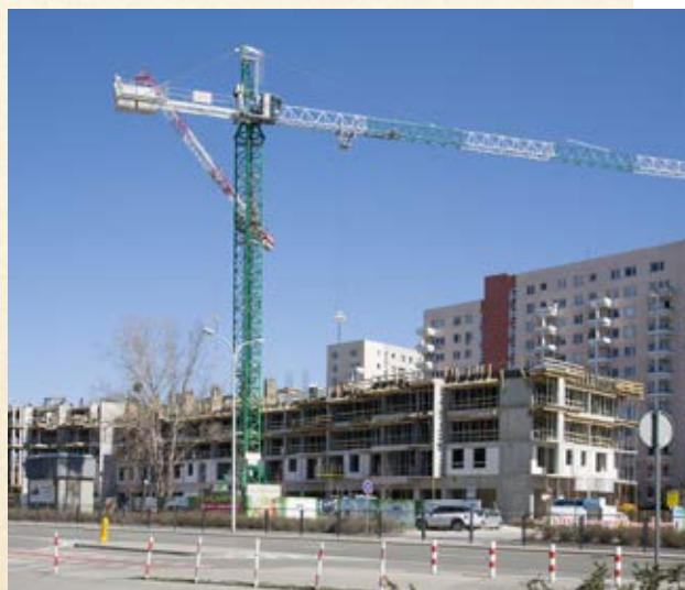
Inwestycja przy ul. Sonaty w trakcie budowy
