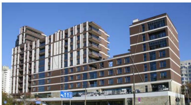
Inwestycja WAŁBRZYSKA 21 w trakcie budowy (2025)
