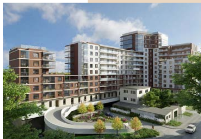
Powyżej – wizualizacja budynku przy ul. Wałbrzyskiej 21
