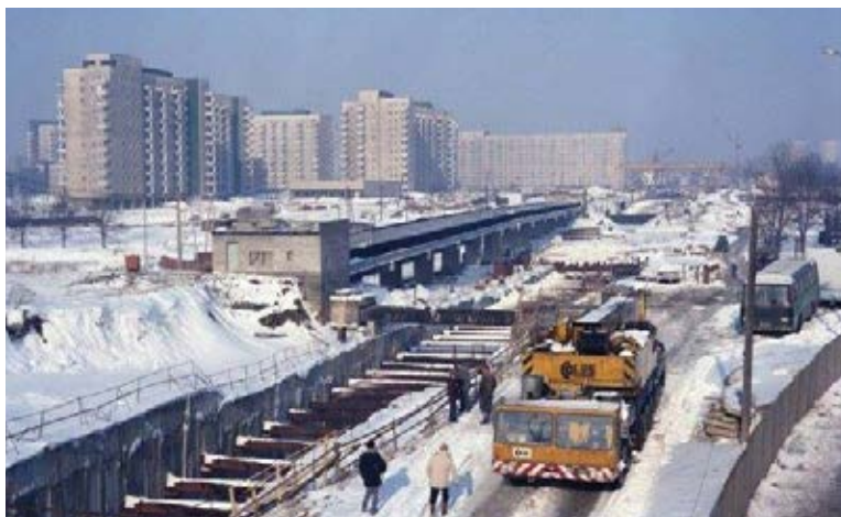
Budowa pierwszej linii warszawskiego metra
