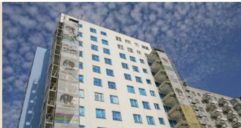
Odnawianie elewacji budynku przy ul. Mozarta 6
