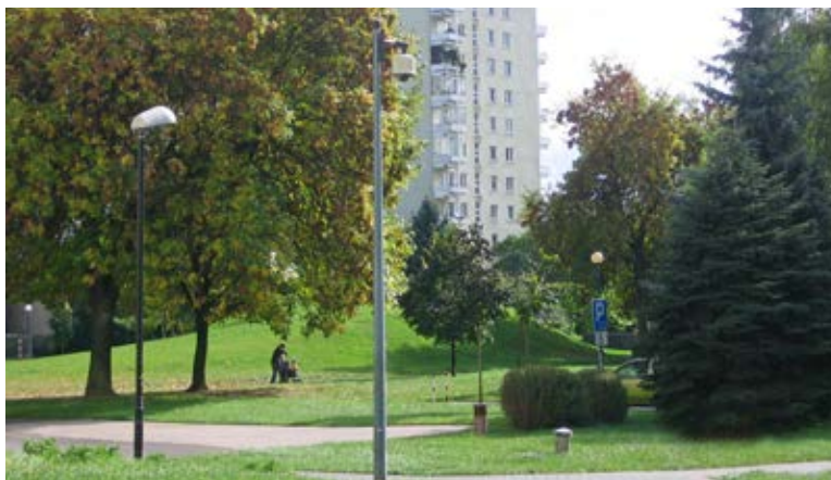
Jedna z kamer obrotowych na terenie Osiedla
