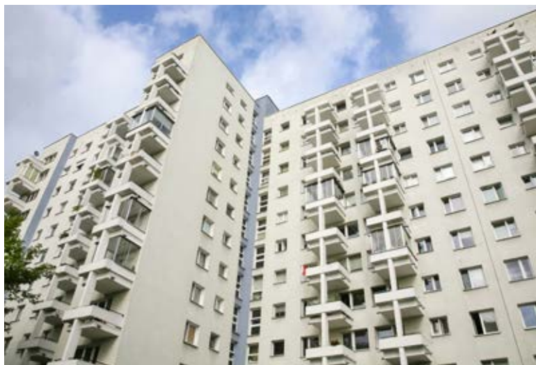
W budynkach przeprowadzono szereg prac remontowych
