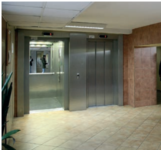
Prace remontowe w budynkach obejmowały również wymianę wind
