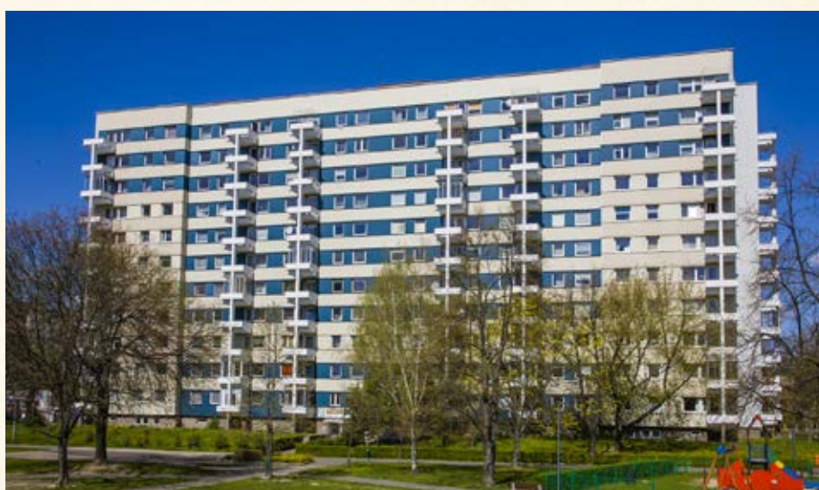
Jeden z pierwszych budynków mieszkalnych na Osiedlu przy ul. Wałbrzyskiej 19, zwany „chemikaliowcem”
