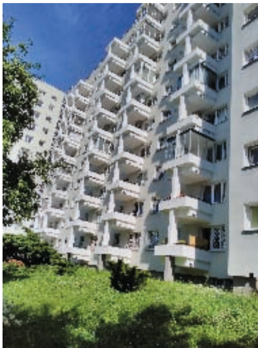
Tak prezentują się świeżo odremontowane balkony w budynku przy ul. Bacha 34
