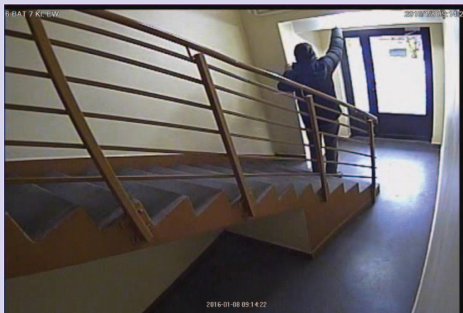
Uszkodzenie świetlówki przez wandalę w budynku przy ul. Batuty 7
