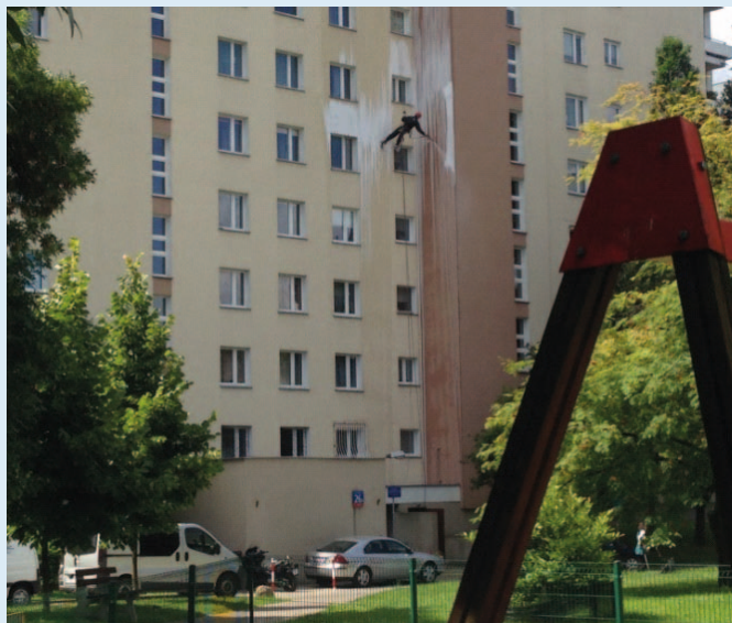
Usuwanie nalotów z elewacji budynku przy ul. Bacha 26B
