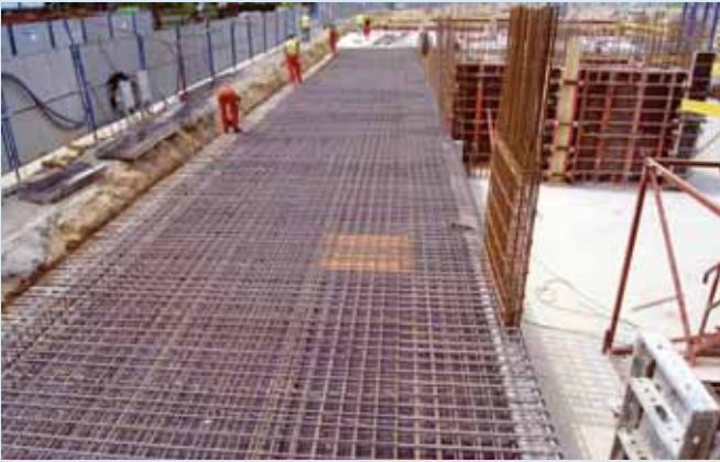
Postęp robót na budowie przy ul. Mozarta widać gołym okiem
