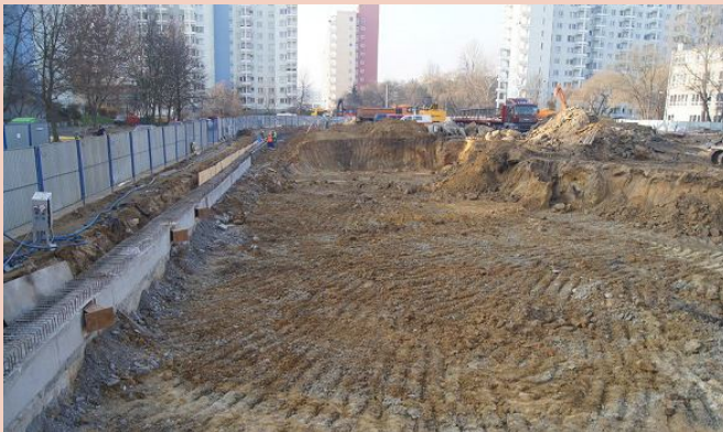
Postęp na budowie przy Mozarta widać z dnia na dzień
