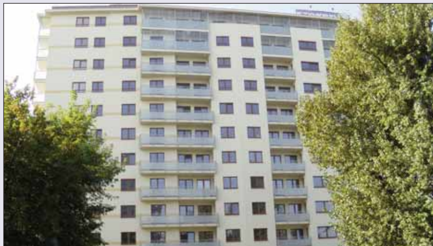
■ Nowo oddana inwestycja Spółdzielni przy ul. Puławskiej 255
