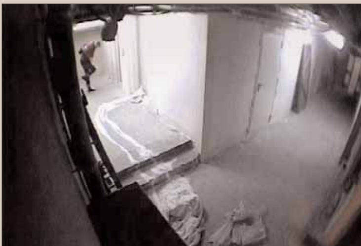
■ Ul. Wałbrzyska. Dewastowanie klatki schodowej
