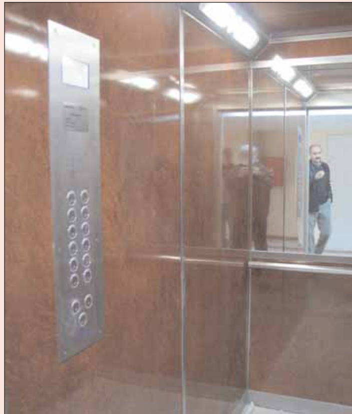
■ Nowoczesne windy towarowe zainstalowane w Spółdzielni...
