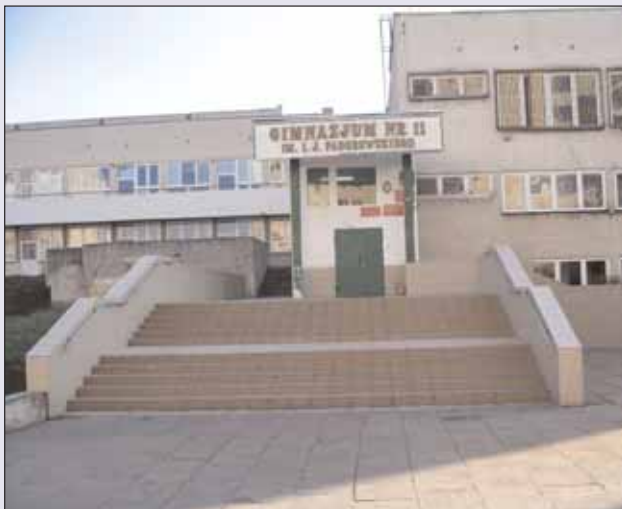
■ Budynek gimnazjum przy ul. Podbipięty 2
