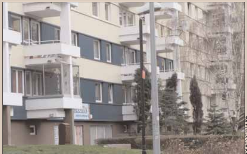
■ Remonty elewacji znacznie poprawiają wygląd budynków
